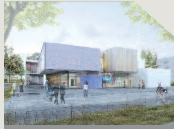
FUTURE MAISON DE QUARTIER CHANTEREIGNE
