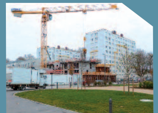
TRAVAUX AU POINT DU JOUR
