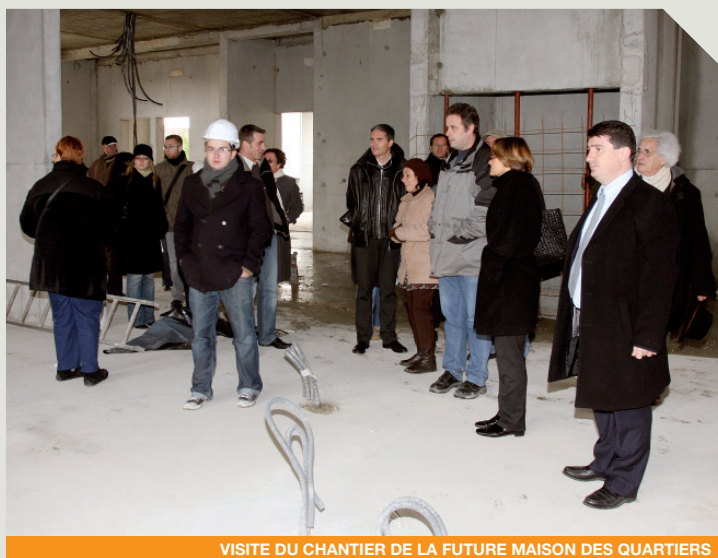
VISITE DU CHANTIER DE LA FUTURE MAISON DES QUARTIERS
